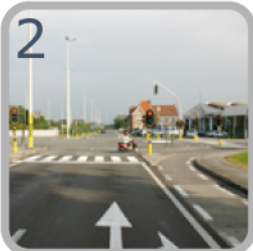
2 Kruispunt Expressweg/ Gistelse Steenweg
